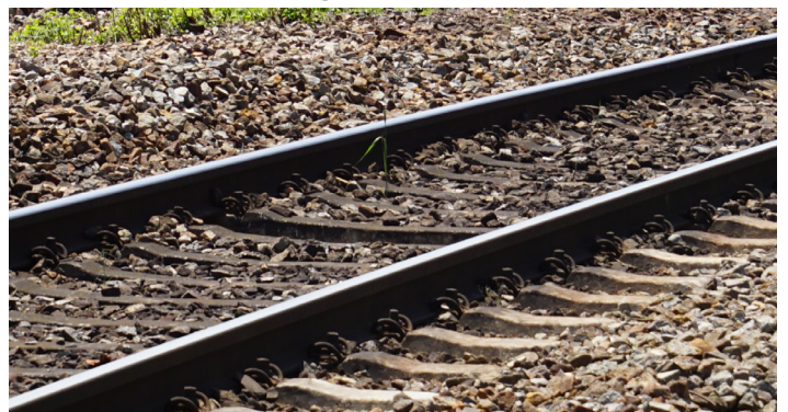
Bahnschotter im Gleisbett
